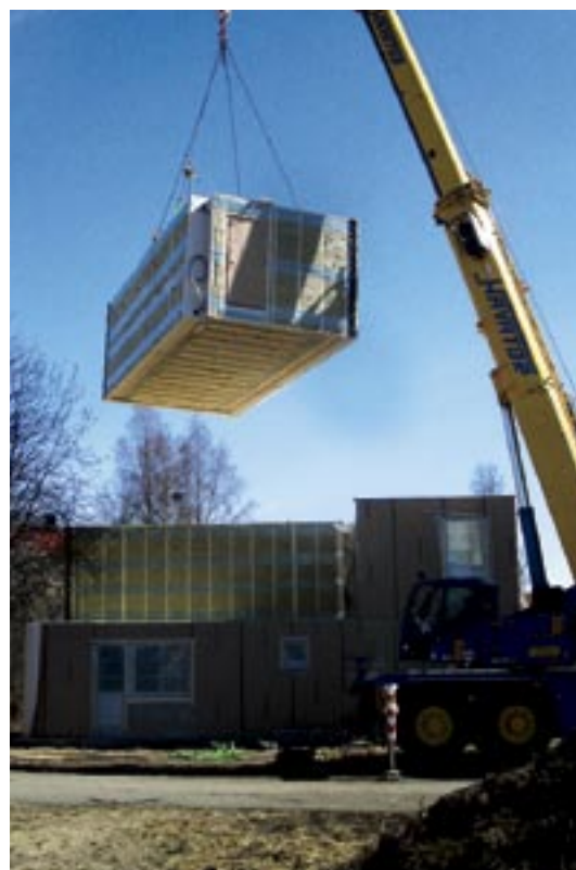
Volymelement till ett flervåningshus med trästomme slutmonteras på byggsplatsen.
