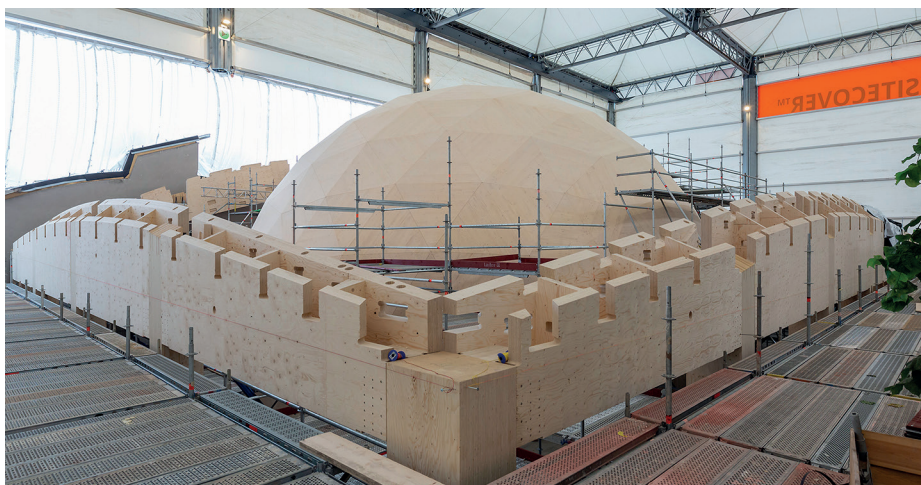
Figur 3: En halvklotformig kupol av prefabricerade CLT-element med millimeterprecision.
