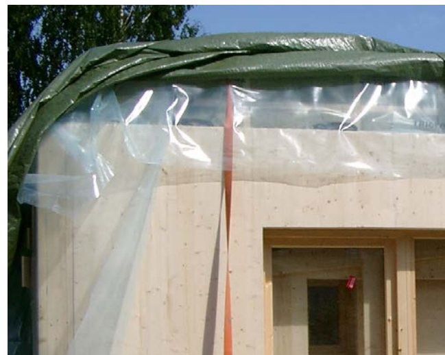
Prefabricerade väggelement på väg att avtäckas.
