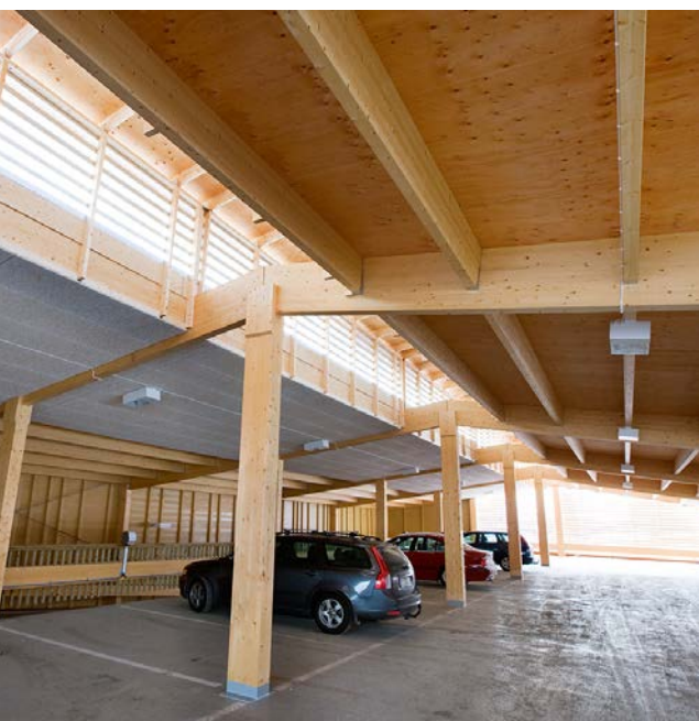
Parkeringshus i limträ och bjälklag i KL-trä.
