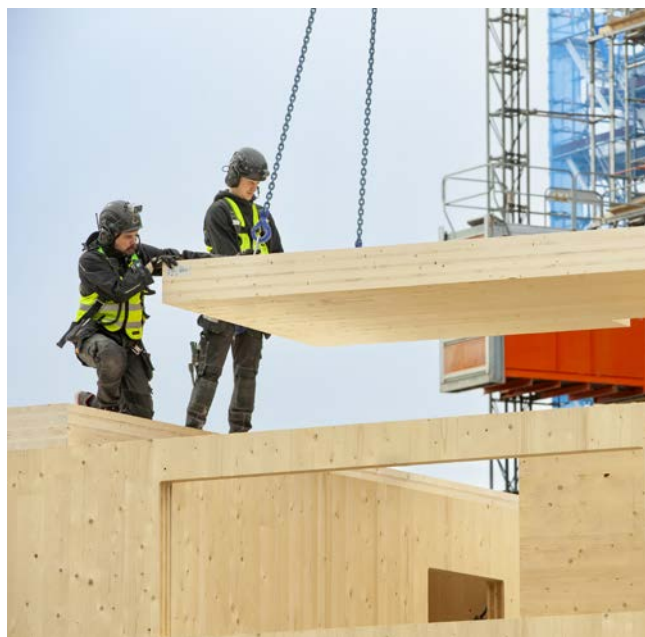
Montage av bjälklagsplatta av KL-trä.
