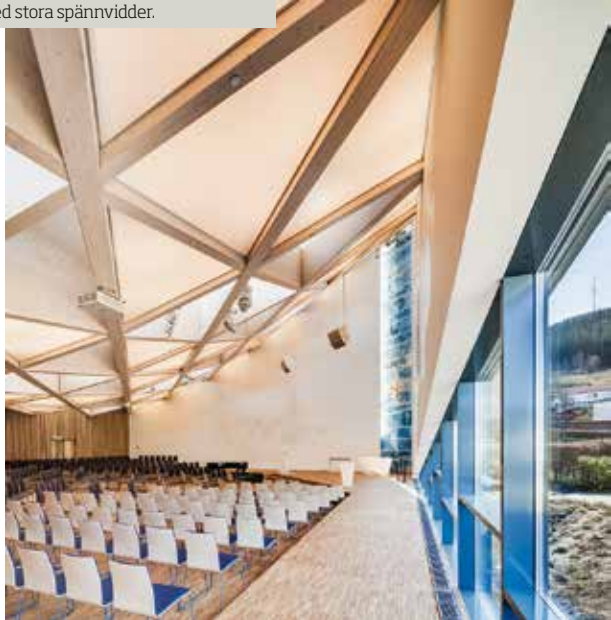
Största spannet i taket är 22 meter. Limträbalkar av gran utgör stommen, ett idealiskt material i byggnader med stora spännvidder.
