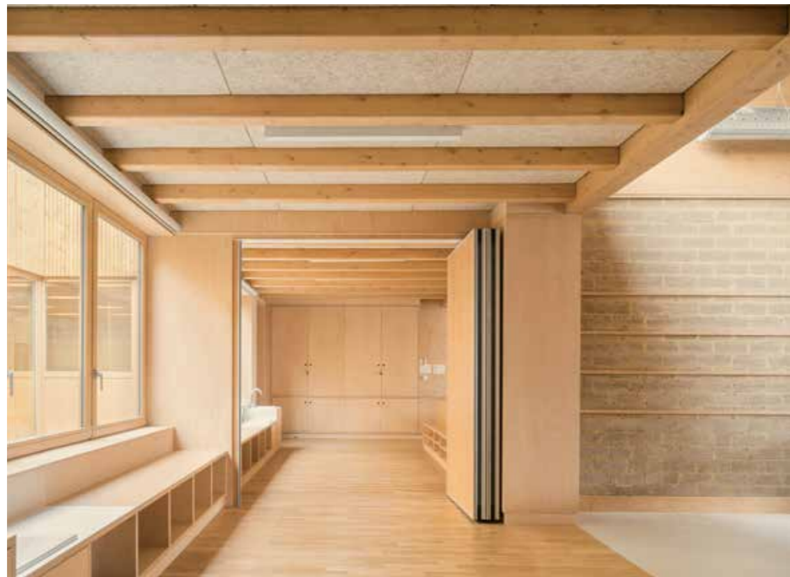
Byggnaden har sida vid sida med de bärande murverken en bärande stomme av KL-trä och limträ samt innerväggar av stampat lufttorkat lertegel.
