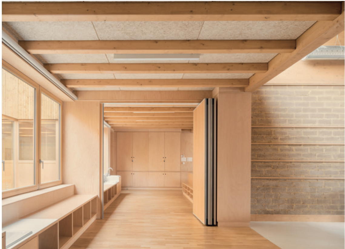
Byggnaden har sida vid sida med de bärande murverken en bärande stomme av KL-trä och limträ samt innerväggar av stampat lufttorkat lertegel.
